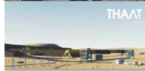
塔温陶勒盖煤矿装煤物流中心”项目
