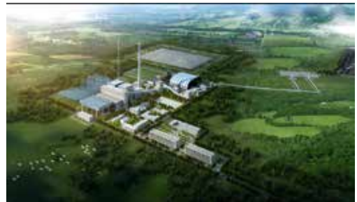
BUURULJUUT POWER PLANT PROJECT
