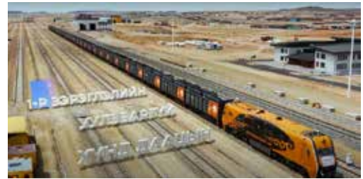
塔温陶勒盖煤矿至噶顺苏海图口岸铁路综合体项目
